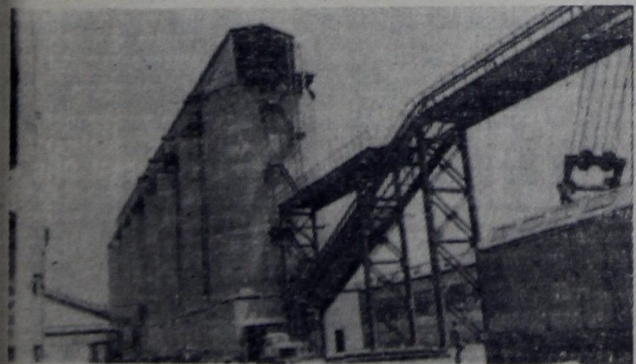
Уже не за горами тот день, когда на Всесоюзной ударной комсомольской стройке будет поднят алый стяг по случаю получения первой партии минеральных удобрений. Объекты и технологическое оборудование первой очереди производства двойного суперфосфата уже накануне начала комплексного опробования.
