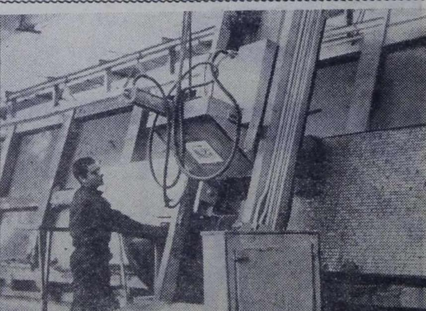
**Москва.** В эти дни трудовой вахты в честь 50-летия образования СССР на Бескудниковском комбинате строительных материалов и конструкций № 1 пущена в эксплуатацию мощная конвейерная линия по производству панелей для строительства новых жилых до-
