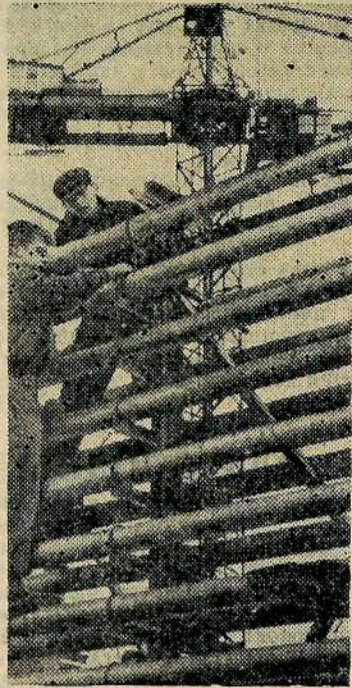
Рабочие СМУ-72 ведут монтаж оросительных доводильников в сернокислотном цехе комбината искусственного волокна.
