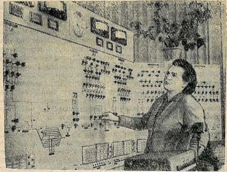
Лабораторией автоматики и телеуправления отделения электрификации железных дорог Центрального научно-исследовательского института железнодорожного транспорта, Министерства путей сообщения СССР создана бесконтактная система БСТ-59 для телеуправления устройствами энергоснабжения электрифицированных железных дорог.
