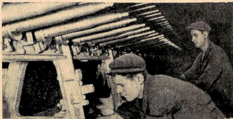
Полным ходом идет монтаж оборудования в корпусе корда № 1. На снимке: слесари-монтажники Степан Гребейников и Владимир Шустов из бригады тов. Курдакова монтируют тростильно-крутильный станок.
