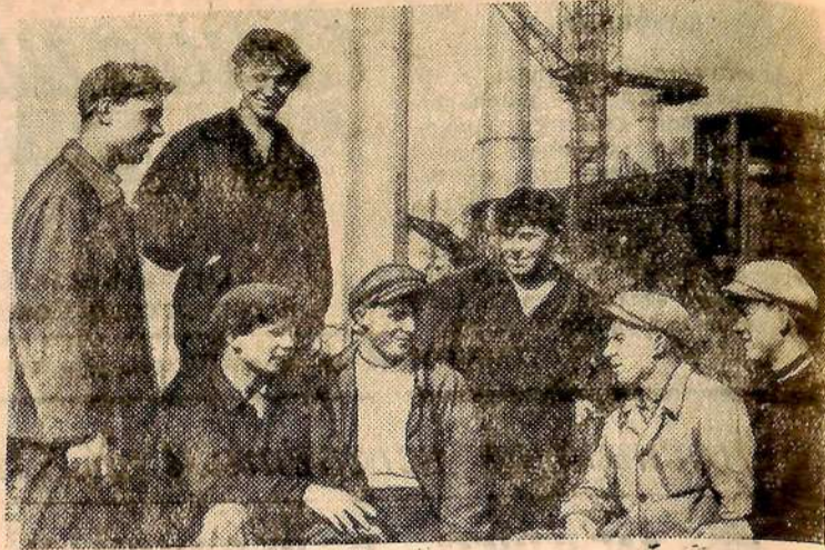
На Магнитогорском металлургическом комбинате заканчиваются строительство мощной мартеновской печи.
