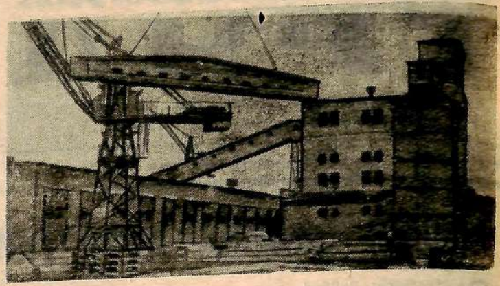
Погрузка готовых изделий для сооружения комбината искусственного волокна на комбинате строительных деталей. Фото И. Сидоренко.
