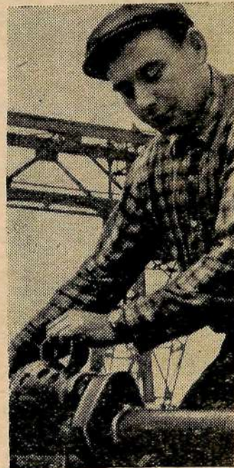
На монтаже котла Балаковской ТЭЦ хорошо зарекомендовал себя слесарь-монтажник тов. Мусин. Сейчас он трудится на одной из строек нашей страны. На снимке: тов. Мусин. Фото И. Сидоренко.
