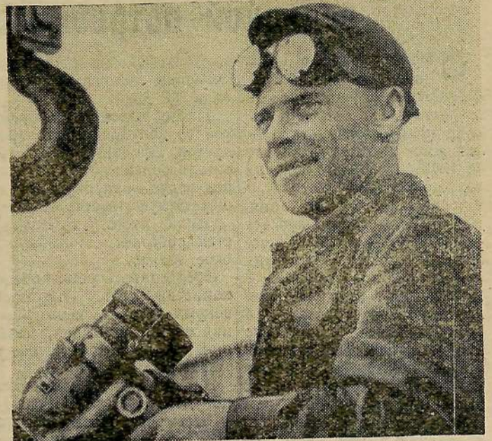
Монтаж парового котла Балаковской ТЭЦ ведет бригада тов. Семченко. На снимке: слесарь-монтажник этой бригады тов. Посредников за работой.
