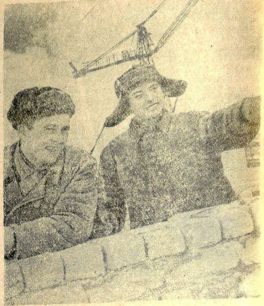
Хорошо трудится на строительстве комбината искусственного волокна бригада Николая Карпова. Она систематически перевыполняет задания и дает высокое качество строительных работ. На снимке (слева направо): передовые каменщики Ю. Пророков и В. Карпов.
