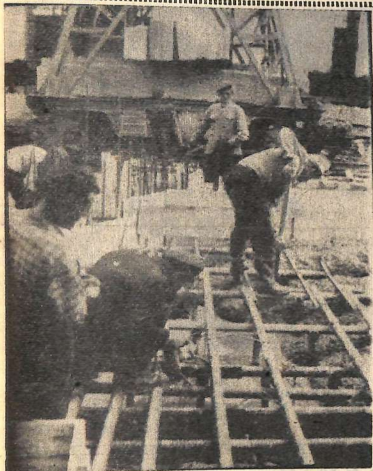
На Саратовской ГЭС продолжаются строительные работы. На снимке: бригада Евгения Борисова из первого строительного управления ведет работы на перекрытии машинного зала. Фото С. Резника.
