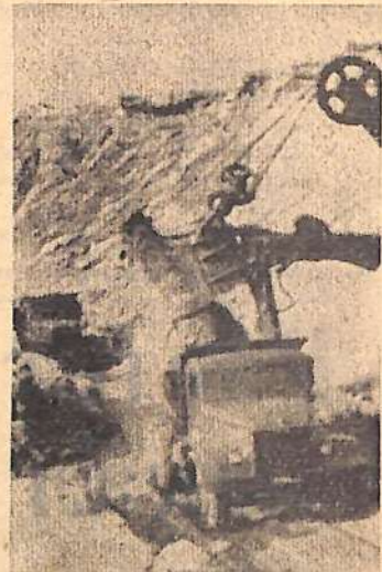
День и ночь идет засыпка ладух шлюзов. Участок инженера Николая Мошкина из управления механизации наращивает темпы. Сейчас механизаторы отсыпают сюда до восьми тысяч кубометров грунта. Они намерены в начале марта довести выработку до 10—11 тысяч. Фото М. Бабенко.
