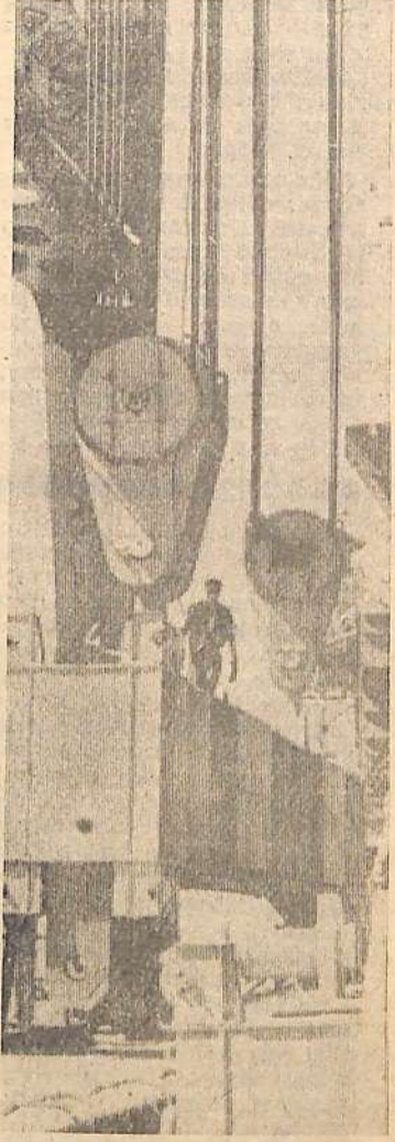
Бригада Овчинникова ведет бурку защитной балки. Фото М. Бабенко.
