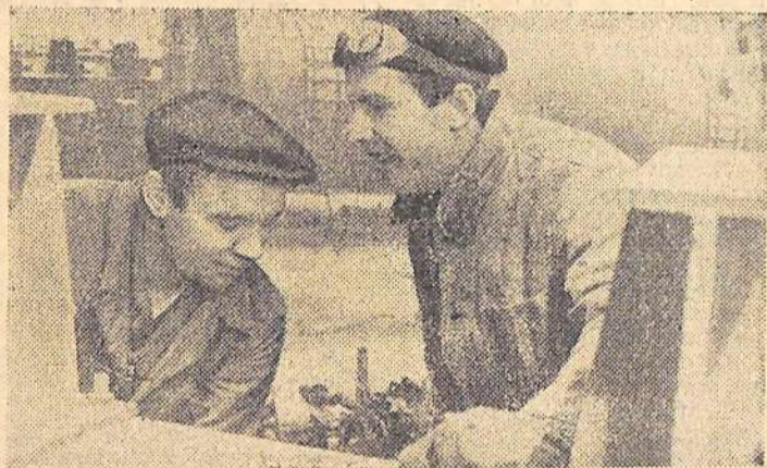
В бригаде Н. Дзюндзика много отличных монтажников. На снимке нашего корреспондента В. Климченко и В. Русаков.
