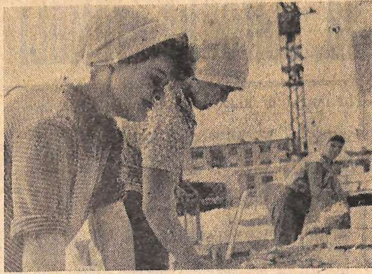
Не ослабевают темпы на строительстве жилья. Каменщицы из бригады Юрия Себякова — Валентина Зверькова, Галина Семенова и Надежда Захарова на кладке стен. Фото Ю. Варакина.
