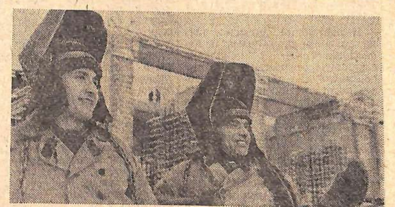
Добрыми делами славятся на строительстве Саратовской ГЭС молодые электросварщики Григорий Дзюба и Эдуард Федотов из седьмого строительного управления.
