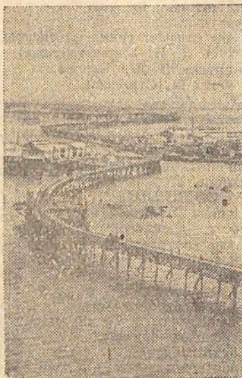
Азербайджан. Уникальный нефтепромысел, в открытом море — Нефтяные Камни. Длина его эстакад достигла 180 километров. Нефтяные Камни и другие морские промыслы республики дают сейчас более половины всей нефти, добываемой в Азербайджане.
