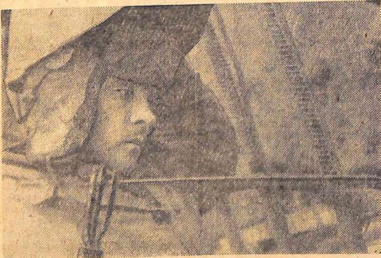
Юрий Деревянкин — электросварщик треста «Гидроэнергоспецмонтаж» — выполняет сварку закладных деталей под облицовку статоров турбин Саратовской ГЭС. Он ведет сварку с высоким качеством.
