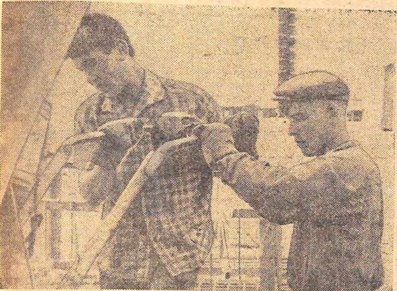
Комплексная бригада Виктора Кожанина ведет подготовку к монтажу крупногабаритных элементов на гидростанции. И сейчас на этом снимке вы видите, как Виктор Кожанин (справа) вместе с Габидином Шакировым укладывают бетон в корзины опорных тумб.
