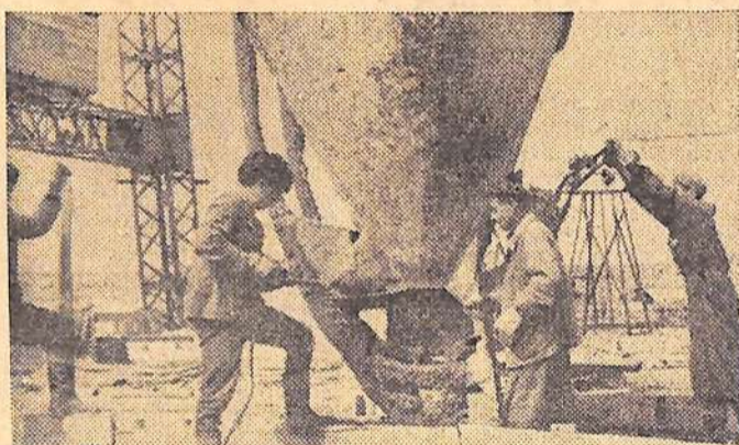
Идет бетон. Укладку его ведут Алексей Сарсанов, Юрий Шопин, Виктор Леонтьев.
