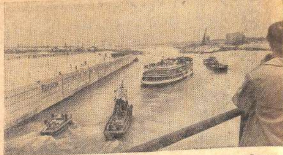
Строители Киевской ГЭС досрочно ввели в действие судовой шлюз. Они переместили 6,5 миллиона кубометров грунта, уложили 124 тысячи кубометров бетона и железобетона, смонтировали свыше 1.000 тонн механического и гидротехнического оборудования.
