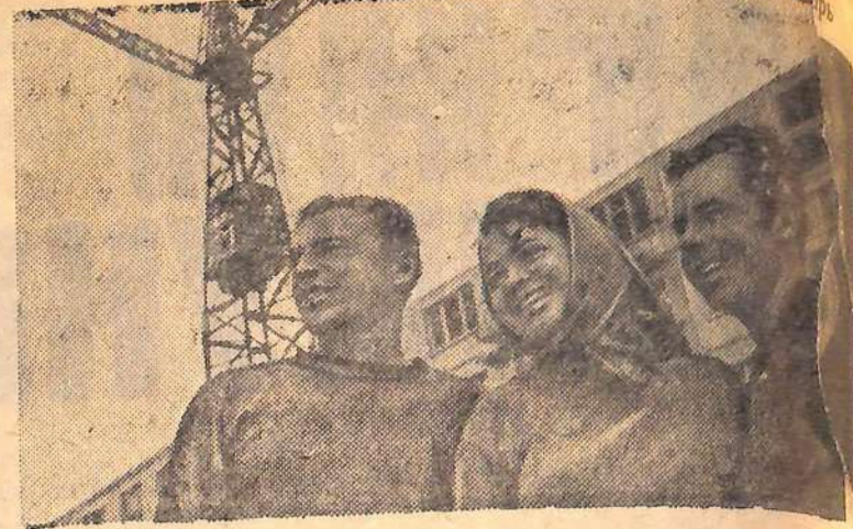
Александр Панасюк, Вера Ус и Павел Тимков — монтажники. Они участвуют в строительстве показательного жилого массива на Дарницком бульваре в Киеве, возводят дома с опережением графика.
