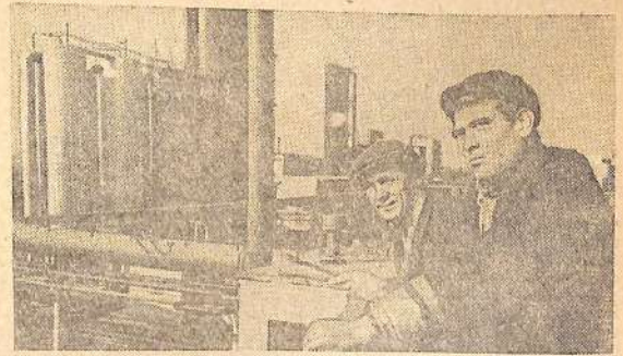
Донецкая область. На строительстве Авдеевского коксохимического гиганта настигли прудовские дни. Готовятся к вводу в эксплуатацию мощная коксовая батарея и комплекс химических цехов. На снимке: передовики треста «Коксхиммонтажстрой» высотники Владимир Цыганок (слева) и Виктор Аллошин. Фото С. Генделемана. Фотохудожник ТАСС.
