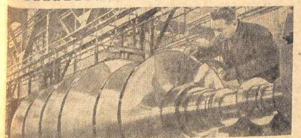
Ленинград. На Невском машиностроительном заводе имени В. И. Ленина с каждым годом увеличивается выпуск мощных агрегатов для металлургической и химической промышленности страны. На снимке: ударник коммунистического труда товарищ Н. Г. Кузьмин за обработкой ротора компрессора для Криворожского металлургического комбината.
