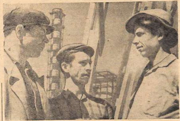
Считанные недели остались до пуска второй очереди комбината искусственного волокна. Скоро места строителей, монтажников и отделочников займут эксплуатационники.
