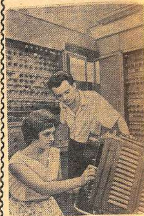
Вычислительный центр, оснащенный новейшей электронной техникой, создается на Харьковском турбинном заводе. Показанные на снимке старший техник Татьяна Литвинова и старший инженер Борис Сорока проверяют работу «памяти» электронно-вычислительной машины.
