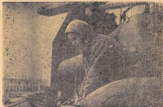
На участке стройтермоизоляции заслуженной славою пользуются изолировщики бригады Марии Федоровны Гамаюновой. Этот передовой коллектив выполнил большую работу по изоляции контактного аппарата на заводе серной кислоты.
