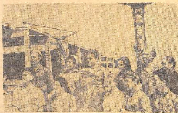
На строительстве второй очереди комбината искусственного волокна успешно
