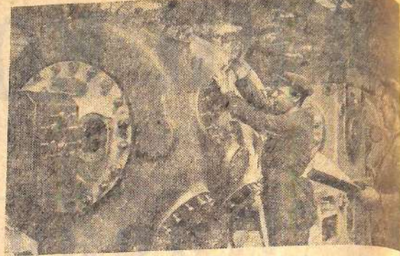
На Сумском машиностроительном заводе имени Фрунзе освоено серийное производство быстроходных компрессоров «5-Т-130/200». В отличие от выпускавшихся ранее версий машины и ее габариты в два раза меньше. На снимке: сборка нового компрессора. Фото А. Загороднего.
