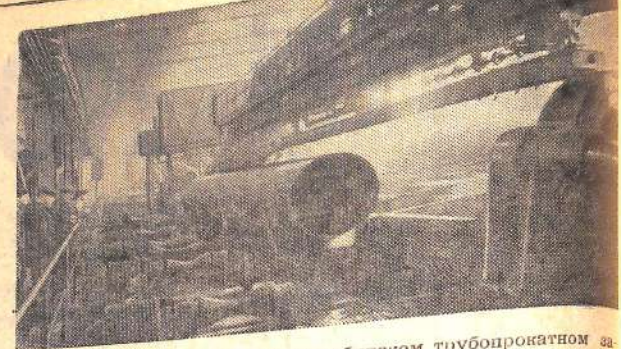
Гигантский стан «1020» на Челябинском трубопрокатном заводе после испытаний приступил к выпуску труб для строительства магистральных газопроводов. Как по площади, так по мощности и технической оснащенности цех не имеет себе равных ни в Европе, ни в США. Стальные полосы проходят путь в несколько сот метров и превращаются в трубы без прикосновения к ним человеческих рук. Трубопрокатчики стали на предмайскую трудовую вахту в венах и празднику выдать 1500 тонн труб сверх задания. На снимке: труба вышла из пресс-расширителя. Фотохроника ТАСС. Фото В. Георгиева.
