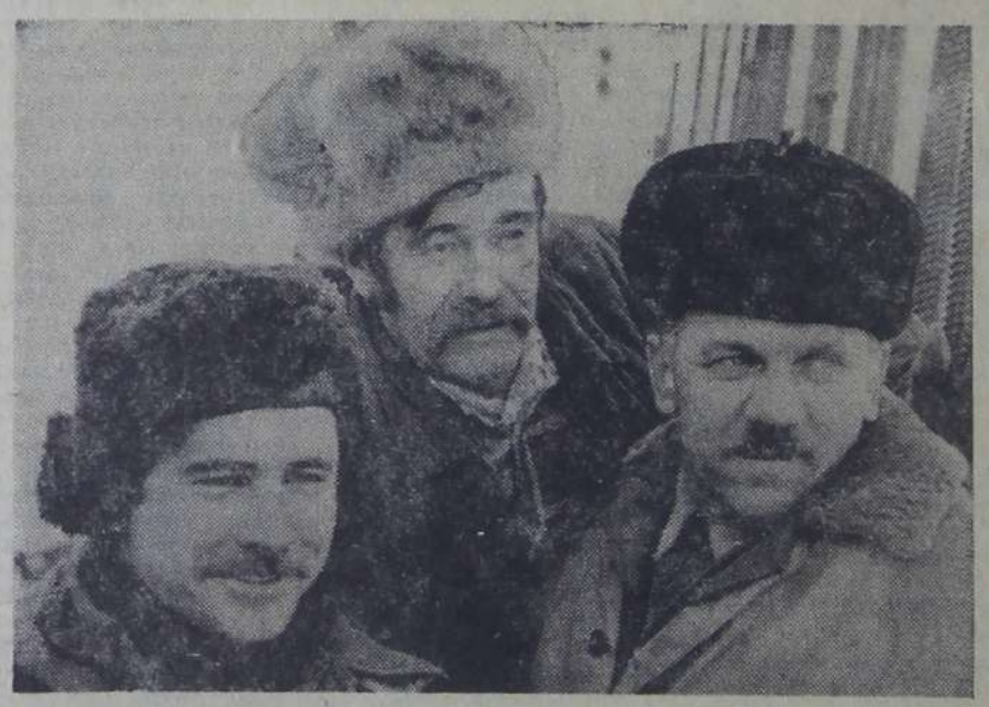
На армировании фундаментной плиты резервной дизельной станции пятого энергоблока АЭС тон в трудовом соперничестве задают коммунисты бригады М. А. Юхнова из управления «Промстрой».
