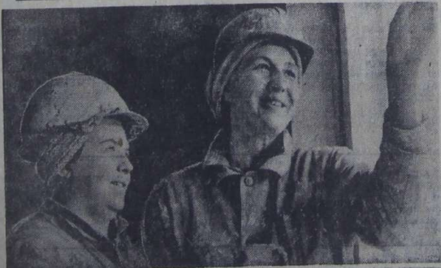
Успешно трудится на сооружении дома № 18 бригада маляров, которой руководит Т. Г. Охлопкова. Это старейший коллектив в управлении «Жилстрой». Почти половину бригады составляют ветераны, они охотно делятся с молодежью знаниями и опытом. Здесь проходит прантину учащиеся подшефной школы № 14, часть из них пополняет ряды коллектива.
