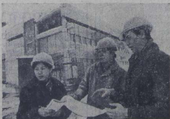
Фрунзенском районе столицы республики, ведется строительство АТС и поликлиники.
