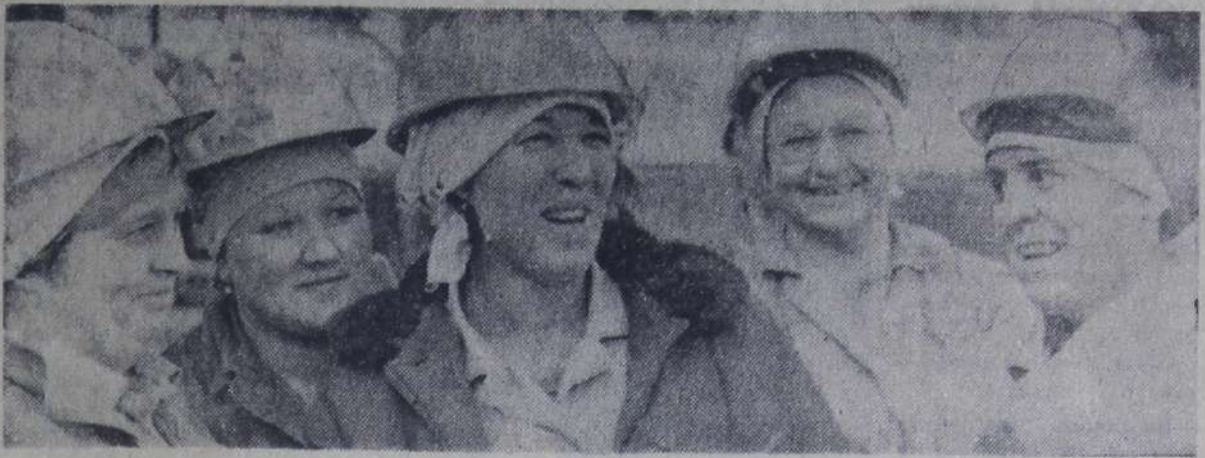
Город наш растет и хорошеет. Свой вклад в его строительство вносит коллектив, возглавляемый ветераном труда З. И. Ховановой. Многие в бригаде помнят, как возводились деревянные двухэтажки в Жилгородке — временное жилье первостроителей Балакова. Теперь бригада сооружает многоквартирные высотные дома, кинотеатры, магазины, гос-
