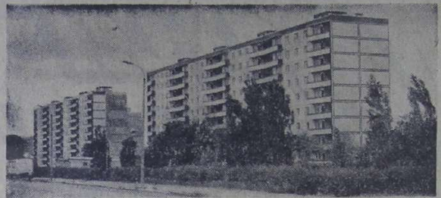
Еще недавно стояли здесь, на улице Факел социализма, старые деревянные домики, и вот уже поднялись два новых современных здания. Закончены последние отделочные работы, идет благоустройство территории. Многие квартиры уже обитаются счастливыми новоселами.
