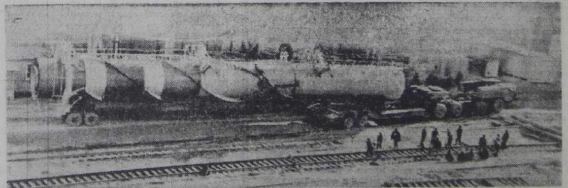
Коллектив бригады, руководимый Ю. И. Кабановым («Гидромонтаж») успешно, в намеченные сроки осуществил подъем и установку вентиляционной трубы на втором реакторном отделении АЭС. На снимке: перед подъемом вентиляционной трубы. Фото М. Бабенко.
