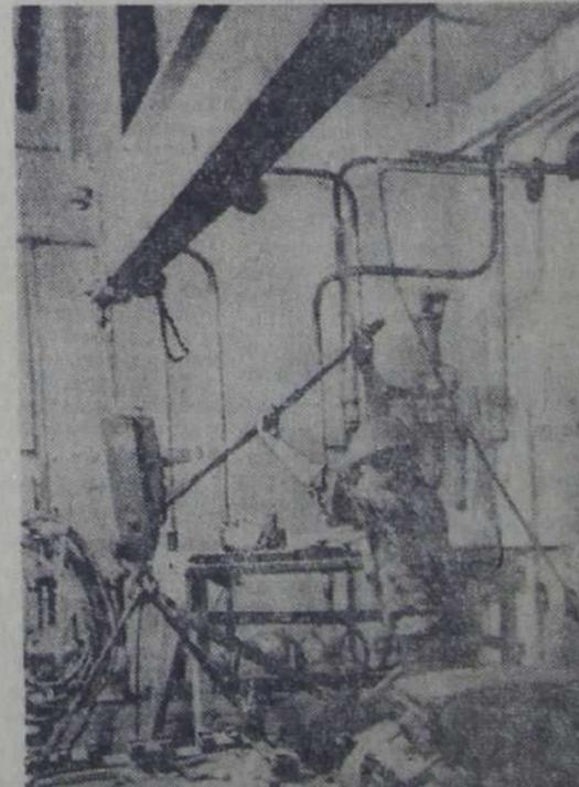
На снимке: в помещении № 326 второго реакторного отделения таким образом монтажники передвигают насосы.
