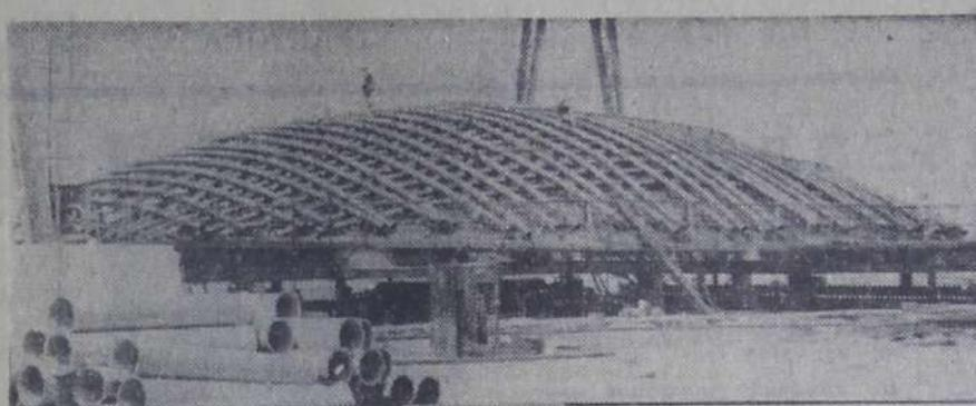
На площадке укрупнительной сборки участка «Гидромонтаж» коллектива бригады В. Н. Немова успешно производят монтаж армоконструкций нижней сетки и каналаобразователей для натяжения пучков купола второго реактора.
