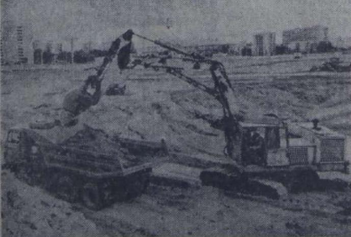
Для увеличения пропускной способности Саратовского оросительного канала коллектив УСМР производит земляные работы по устройству объездной дороги у головной части канала. После монтажа и ввода в эксплуатацию водопонижающего оборудования дорога по набережной Леонова будет перекрыта. Земляные работы будут продолжены по устройству котлована для возведения еще одной водозаборной станции.
