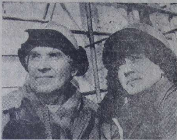
кубометров бетона. На снимке: бригадир Н. Н. Козлов с комсом
