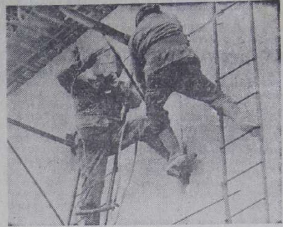
Строится Балаковская АЭС.
