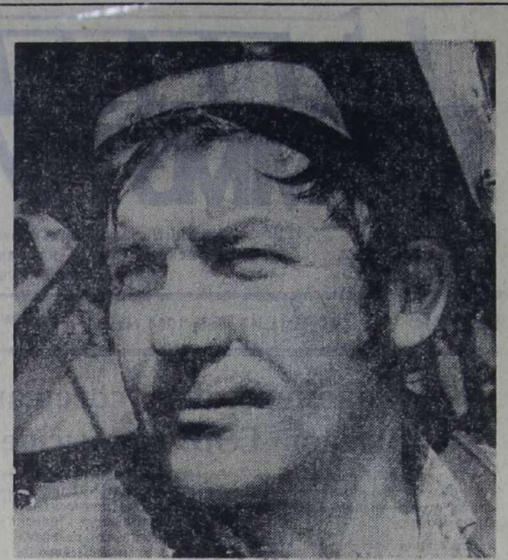
На укрупнительной сборке металлоконструкций купола реактора Балаковской АЭС высоких результатов добивается электросварщик с Волжского участка «Гидромонтаж» Б. Н. Березнаускас.
