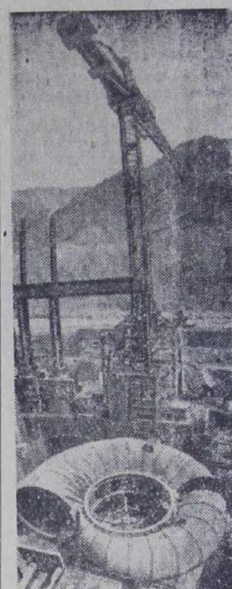
Таджикская ССР. Используя метод укрупненной сборки, завершила монтаж спиральной камеры первого агрегата Бай-пазинской ГЭС, сооружаемой на Вахше, передовая бригада лауреата Государственной премии СССР А. М. Шильникова. Сделан еще один шаг к пуску электрической машины мощностью 150 тысяч киловатт. Монтажники приступили к следующему этапу — сборке рабочего колеса и вала турбины. Напряженно работают строители и на других участках. Начата укладка бетона в основание второго агрегата станции.
