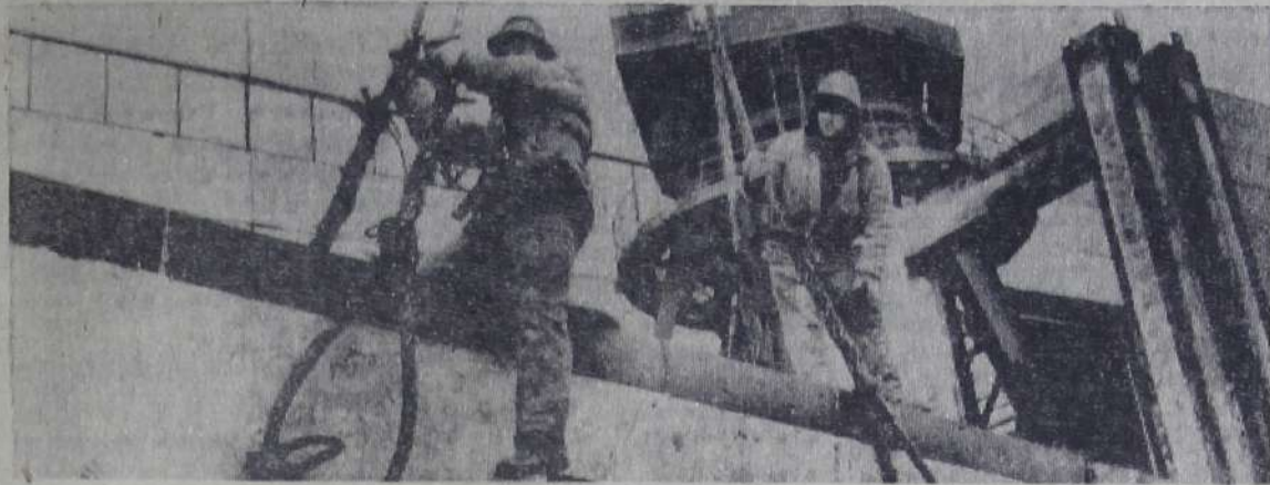
НА СНИМКЕ: установка колонны эстакады; члены бригады А. Т. Кулинич и В. С. Шивовар готовятся к монтажу. Фото М. Бабенко.
