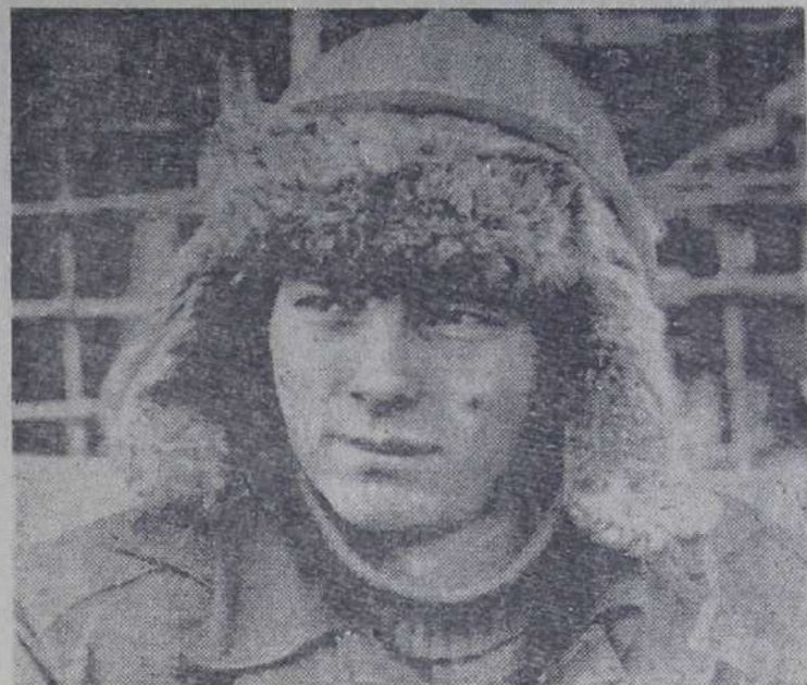
На монтаже металлических и сборных железобетонных конструкций первого реакторного отделения АЭС по-ударному трудится молодой монтажник из бригады Н. П. Деркача Андрей Солдаткин. Работы, которые ему поручают, он выполняет с опережением графиков.
