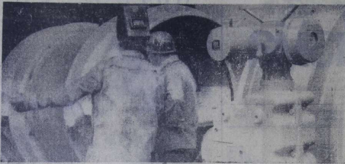
Бригада слесарей-монтажников Балаковского управления треста «Волгоэнергомонтаж», возглавляемая Л. Федоровым, занята монтажом технологического
