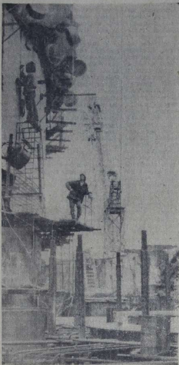
Идет завершающий этап монтажных работ на гермооболочке первого реакторного отделения — подготовка к бетонированию оставшихся участков «рубашки» реактора шестого и седьмого ярусов.
