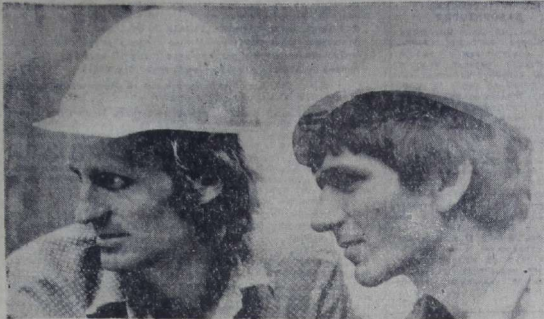
На устройстве опалубки под бетонирование оболочки первого реакторного отделения плодотворно трудился коллектив бригады, руководимой В. И. Бондаренко. В снятые сроки бето-
