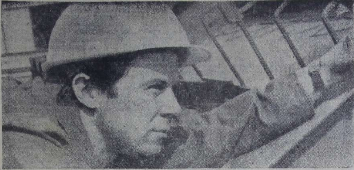
На монтаже металлоконструкций купея первого реакторного отделения АЭС со значительным перевыполнением сменных заданий трудятся монтажники из бригады В. Н. Немова Волж-
