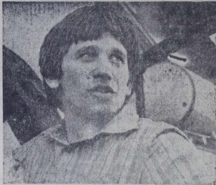
На бетонировании объектов первого реакторного отделения АЭС достойно несет трудовую вахту машинист бетононасоса АТК-2 управления автомобильного транспорта Саратовгэстроя комсомолец Владимир Некрасов.
